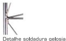
Detalhe soldadura gelosia
